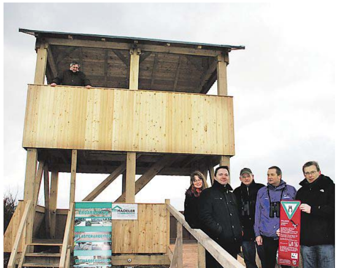
Der neue Aussichtsturm bietet mit seiner rollstuhlgerechten Rampe auch Behinderten einen Zugang. Er wurde gestern von Sabine Fröhlich und Klaus Gänsslen (rechts) vom Fachdienst Naturschutz des Landkreises, Christian Pohl, Leiter der Kies- und Sandwerke der Firma Rhein-Umschlag GmbH, Ingenieur Rainer Kühling und Jens Rösler vom NABU Nienburg eingeweiht.
